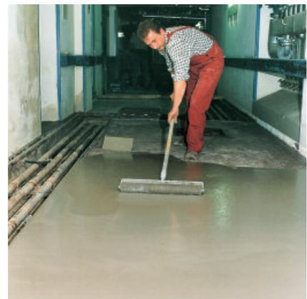
Auf der klebefreien, ausgehärteten Grundierung ausgegossenes und verteiltes PCI Zemtec 1K während des Einbaus mit einer Stachelwalze egalisieren und entlüften.
